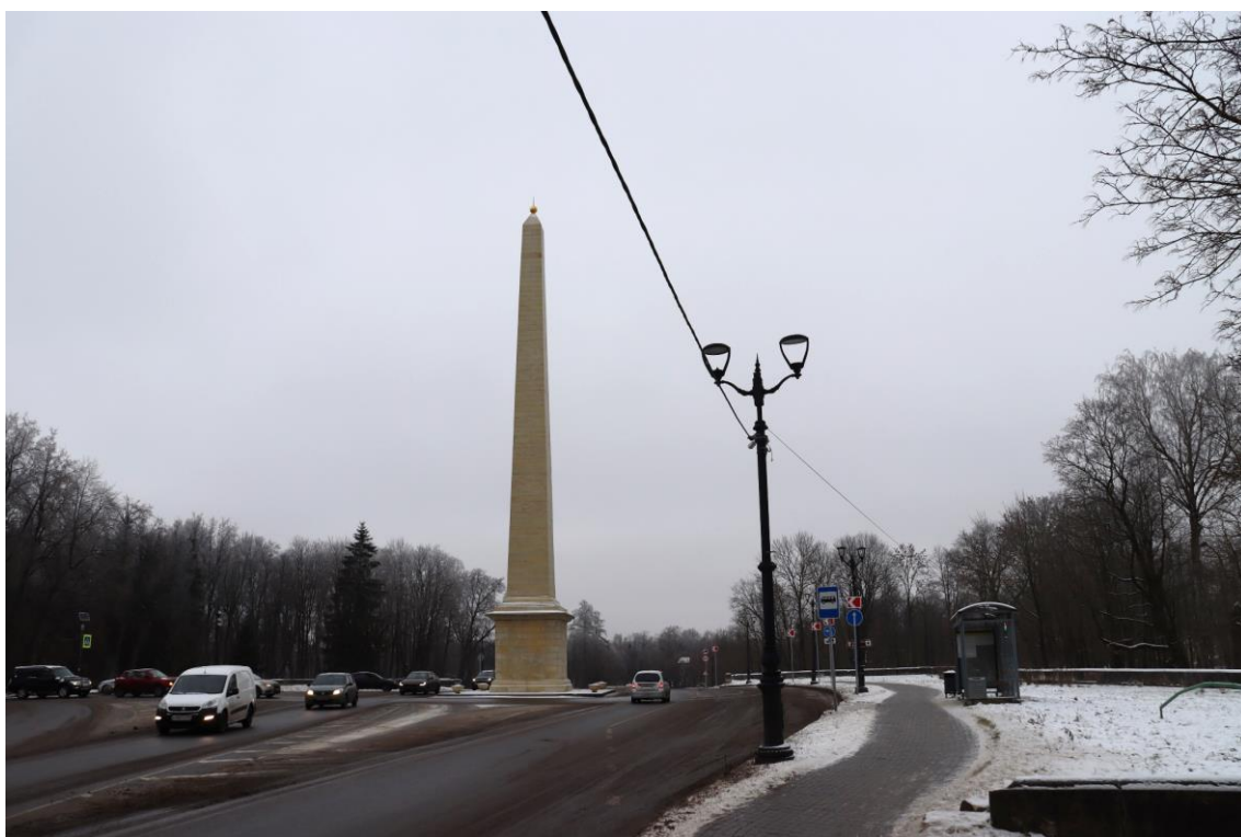
Рис. 6.26. Вид на «Обелиск и площадь «Коннетабля» с подпорными стенками» фотофиксация ноябрь 2022г.
