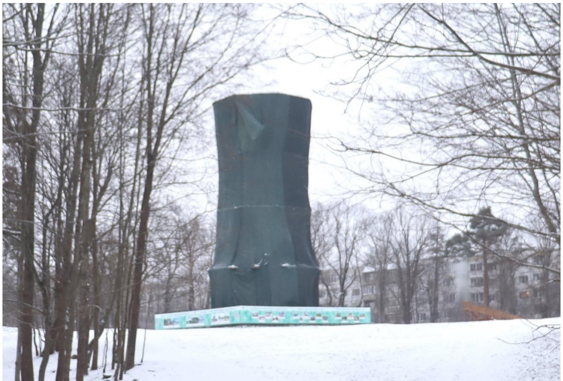
Рис. 6.33. Вид на «Водонапорную башню» с подпорными стенками» фотофиксация ноябрь 2022г.
