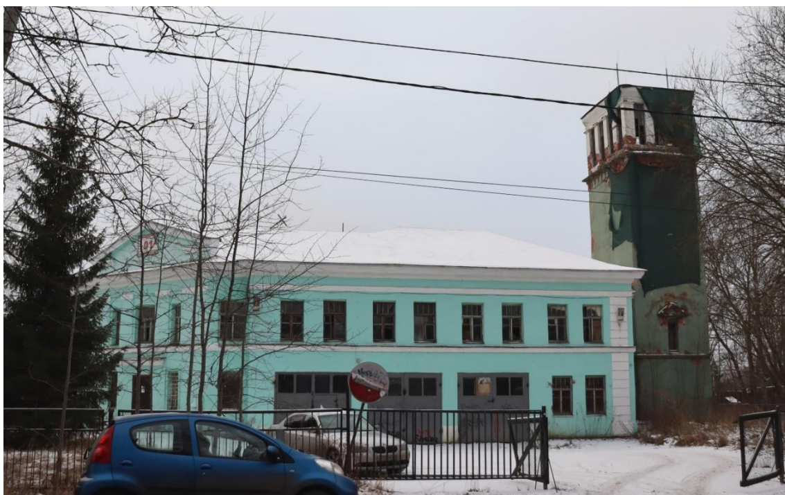
Рис. 6.37. Вид на Пожарную часть фотофиксация ноябрь 2022г.
