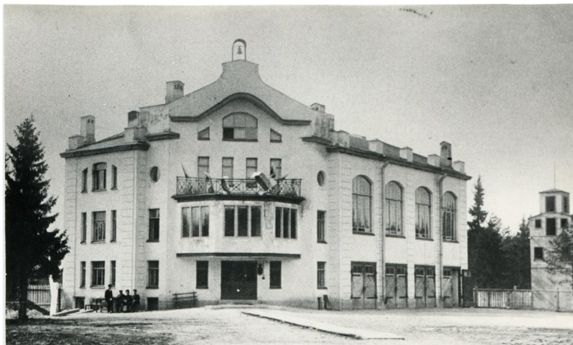
Рис. 6.36. Вид на Здание пожарного депо в Мариенбурге в г. Гатчине. 1912 г. – Режим доступа: https://pastvu.com/p/1029198
