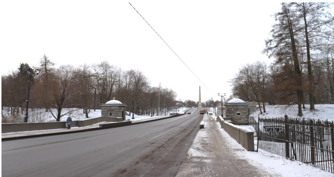
Рис. 5.11. Вид на Обелиск и площадь «Коннетабль» от Адмиралтейского моста и двух кордегардий, фотофиксация ноябрь 2022 г.
