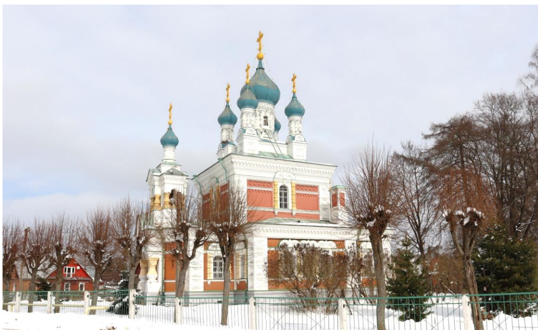
Рис. 5.8. Вид на Церковь Егерской слободки, фотофиксация март 2023 г.
