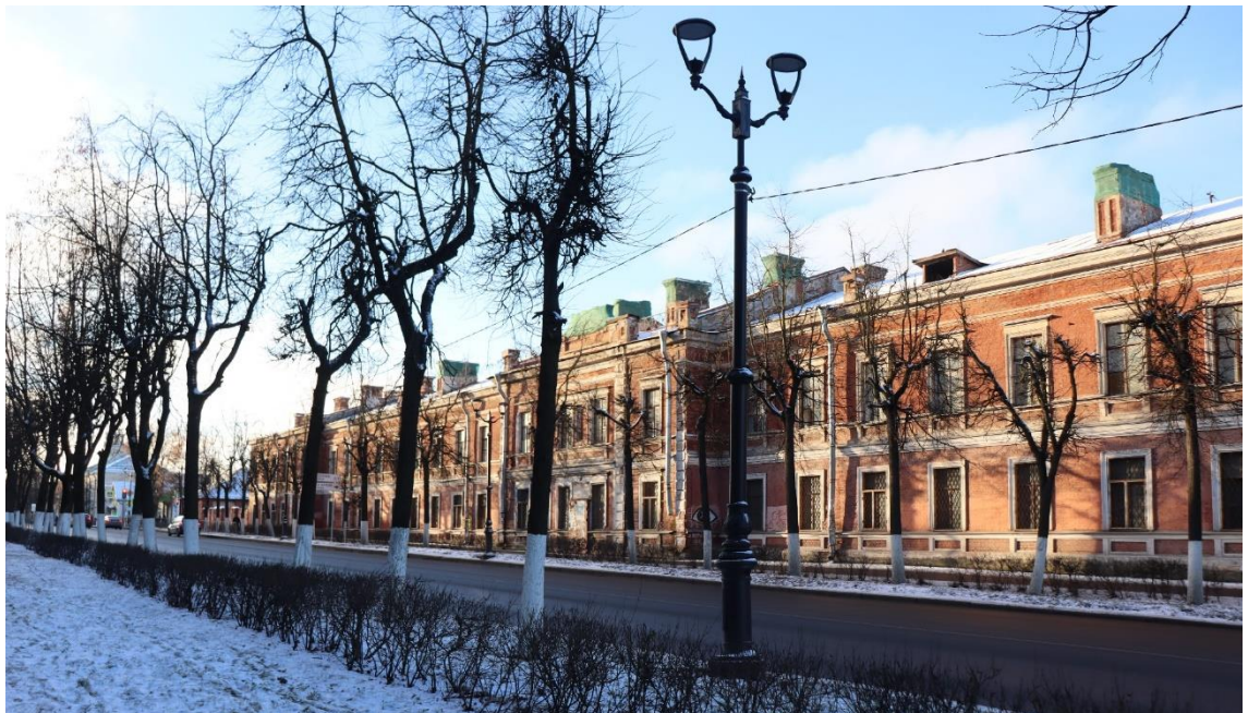
Рис. 5.22. Вид на Центральную казарму ансамбля зданий бывших казарм и жилых зданий гвардейского батальона (ранее крепость Ингербург) с просп. 25 Октября, фотофиксация ноябрь 2022 г.
