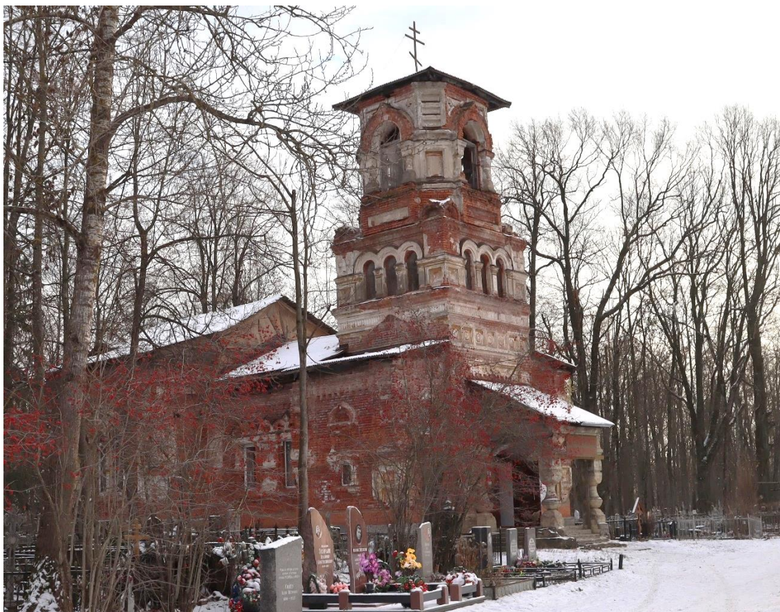
Рис. 6.13. Вид на «Церковь во Имя Всех Святых» на кладбище, фотофиксация ноябрь 2022г.
