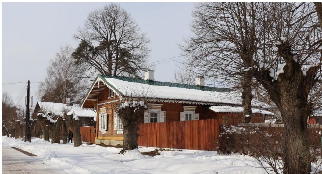
Рис. 5.7. Вид на Ансамбль Егерской слободы: 19 жилых домов, фотофиксация ноябрь 2022 г.
