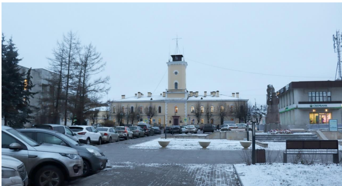
Рис. 6.28. Вид на «Съезжий дом» с подпорными стенками» фотофиксация ноябрь 2022г.
