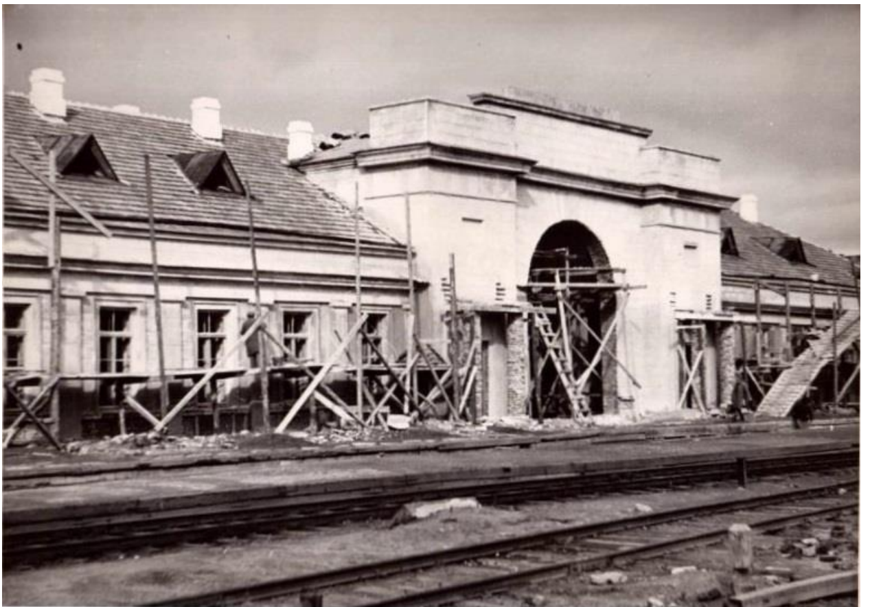
Рис. 3.2.6.16. Вид на строительство нового здания Варшавского вокзала в г. Гатчине. 1945 г. – Режим доступа: https://pastvu.com/p/1025006
