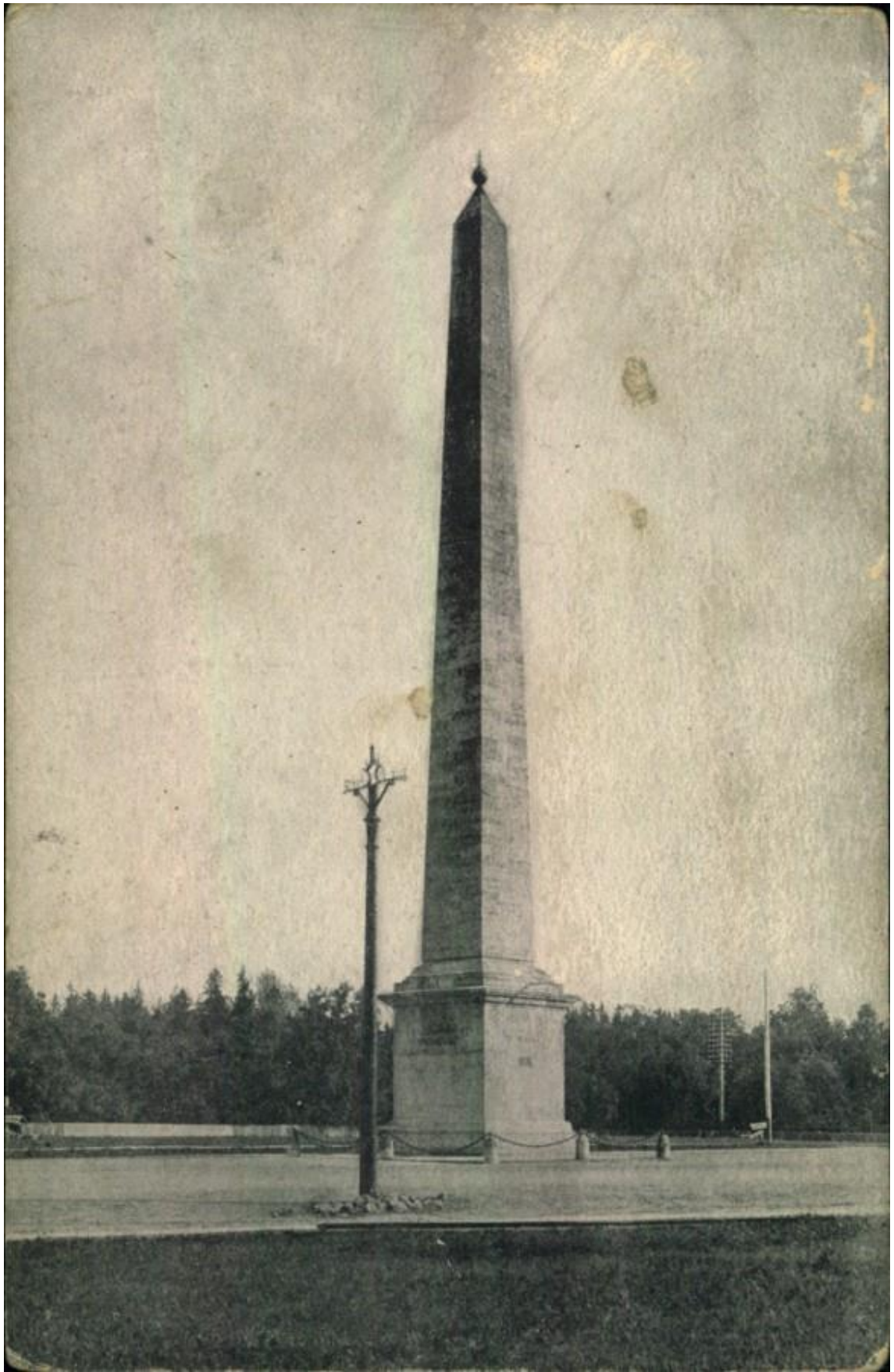
Рис. 3.3.1.19. Вид на «Обелиск и площадь «Коннетабля» с подпорными стенками». 1904 - 1914 гг. – Режим доступа: https://goskatalog.ru/portal/#/collections?id=3902991
