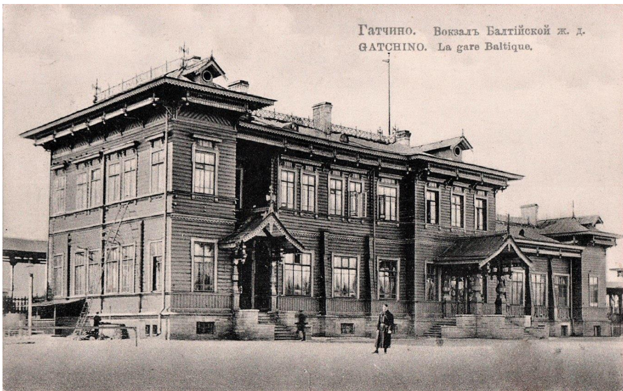
Рис. 3.2.6.7. Вид на здание Балтийского вокзала (был построен в 1890 г., утрачен) в г. Гатчине. 1909 – 1914 гг. – Режим доступа: https://pastvu.com/p/1054822
