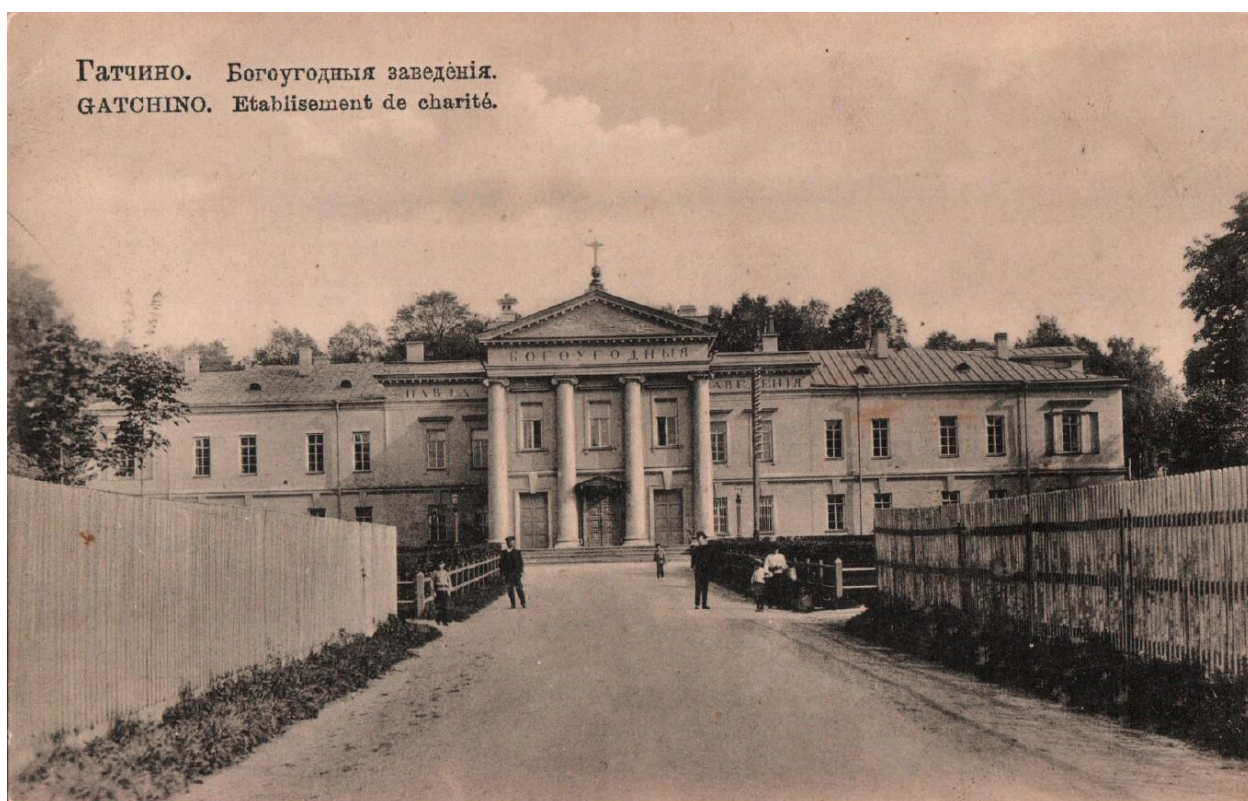
Рис. 3.3.1.9. Вид на здание госпиталя из «Ансамбля Госпитального городка» 1908 – 1909 гг. – Режим доступа: https://pastvu.com/p/930496
